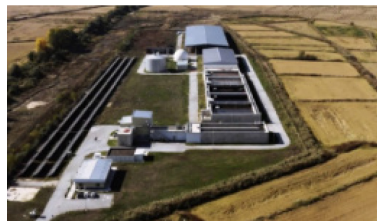
Abbildung 7: Kläranlage Kočani, mit Photovoltaik- und Biogasanlage zur Stromproduktion (Quelle: SECO)
