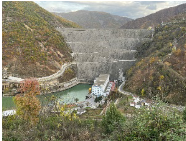
Abbildung 6: Der 150 Meter hohe Fierze-Staudamm und das Kraftwerk am Fluss Drin (Quelle: EFK)
